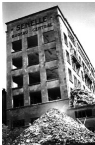
Edificio che ospitava gli uffici della società Usinor-Senelle, Longwy
