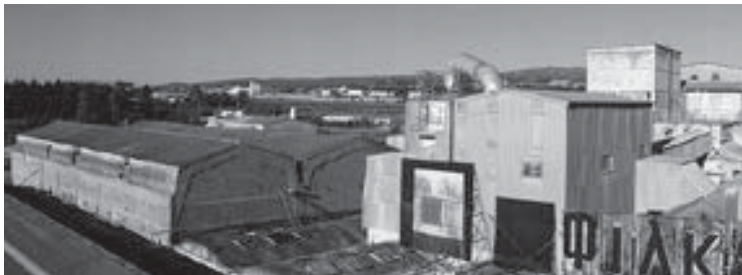
La vista dal tetto del capannone centrale della Vio.Me di Salonico; credit: Mariette Schiltz
